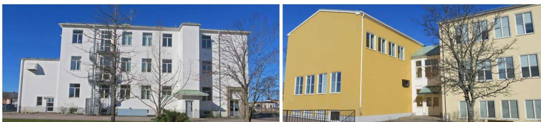
Bild 6 o. 7. Läroverksbyggnaden från 1936 till vänster, de båda sammanbyggda huskropparna från 1950 till höger, Kalmar läns museum 2021.
